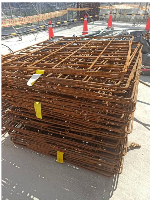
圖一 柱之一筆箍箍筋
