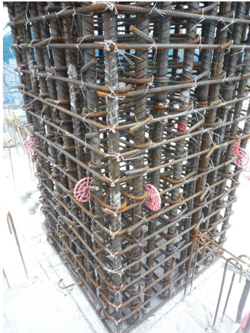
圖一 二向繫筋均疊置於外閉合箍筋之上方案例
